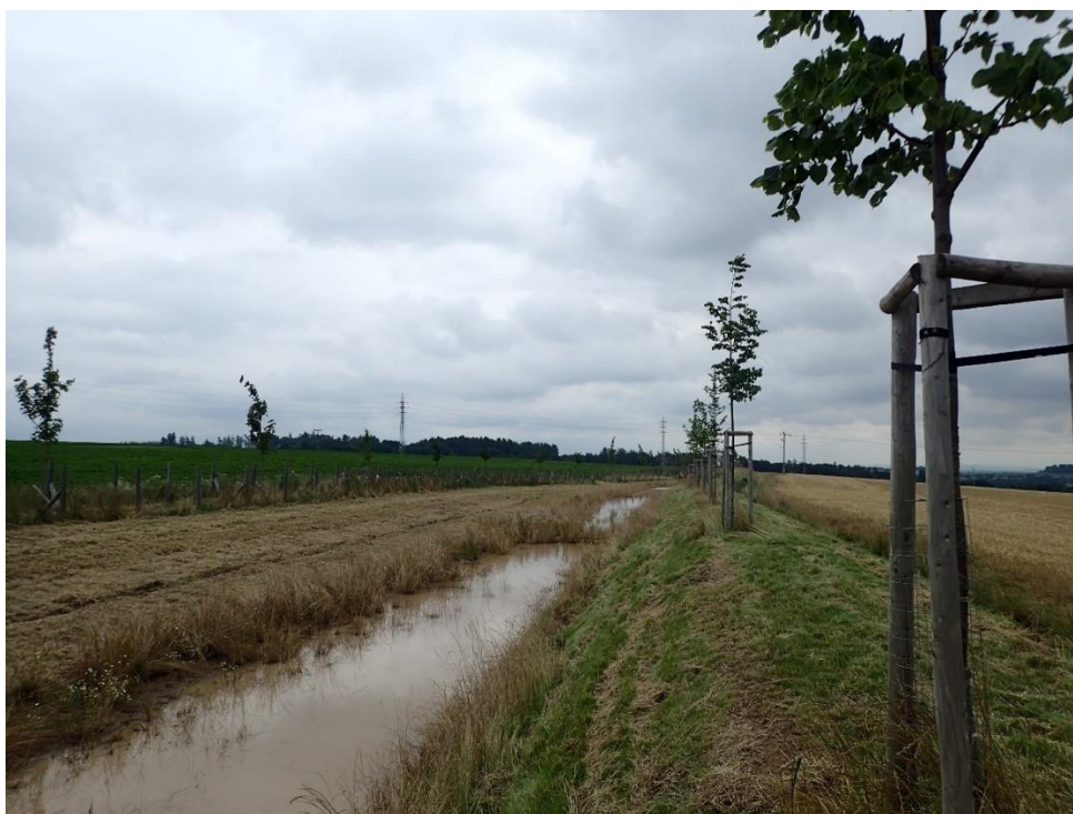
Obrázek 1 Příklad realizace záchytného příkopu po pozemkových úpravách (obec Dubenec, okres Trutnov)
